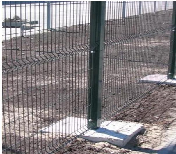
Ограждения ЛЕПСЕ серии «БАРЬЕР» изготовлены из оцинкованной горячим способом проволоки и покрыты полиэфирной порошковой гладкой краской.
